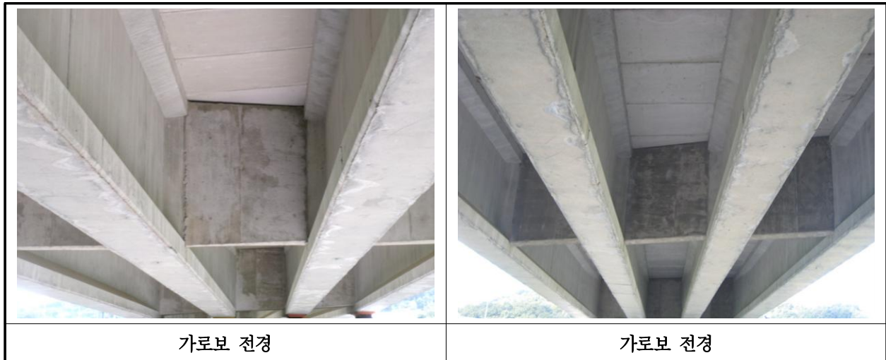
【사진 16.3.6】 가로보 전경
