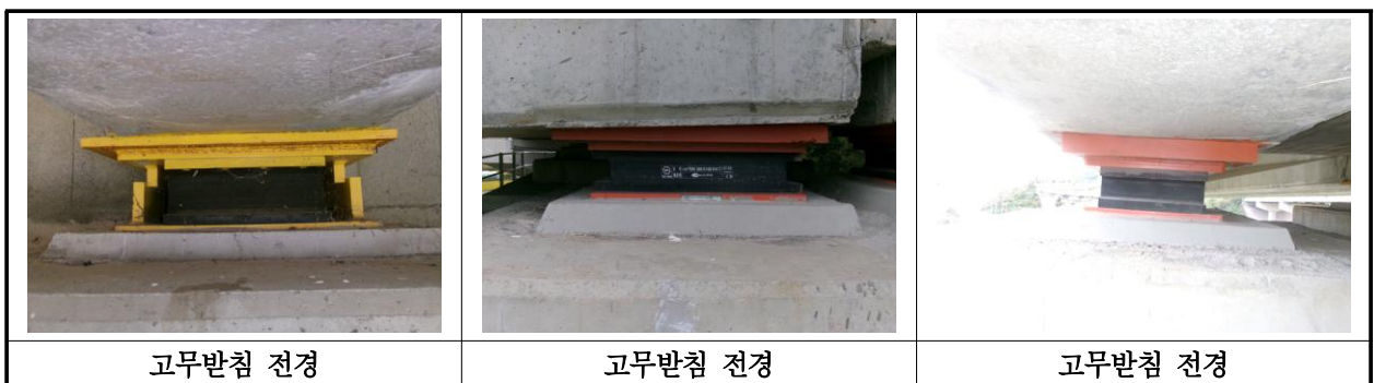
【사진 16.3.12】 교량받침 전경
