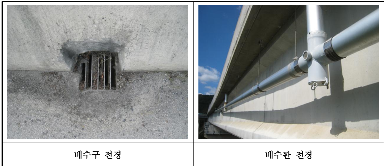
【사진 16.3.21】 배수시설 전경
