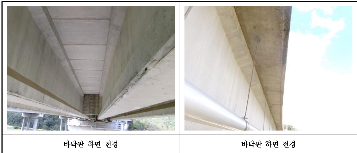
【사진 16.3.2】 바닥판하면 전경
