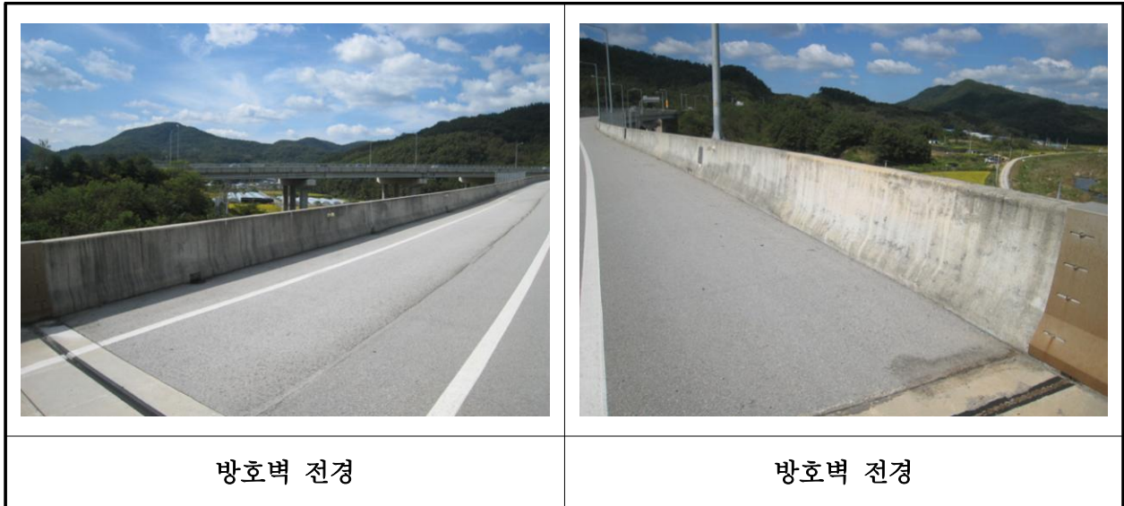
【사진 16.3.23】 방호벽 및 중앙분리대 전경
